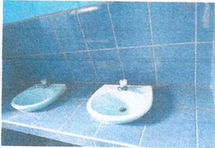
Foto 1: INSTAOLACION DE PISO CERAMICO EN LOS SANITARIOS
