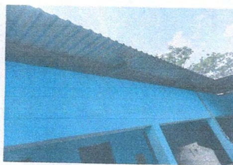
FOTO 4: PINTURA GENERAL DE PAREDES.
