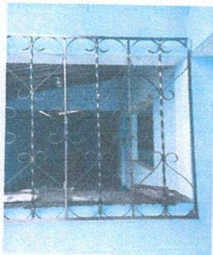
Foto 1: REMOZAMIENTO DE VALCONES
