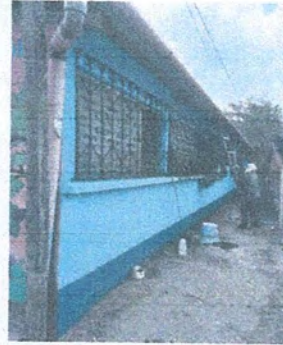
Foto 2: MEJORAMIENTO DE DE AGUAS PLUVIALES
